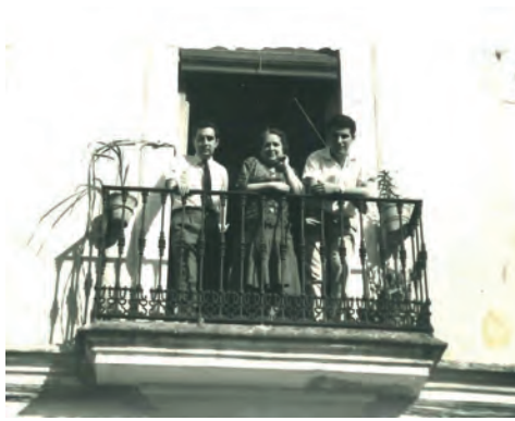
En la sede colegial situada en el piso de la calle San José. Manolo Diaz y Manolo Romeu
